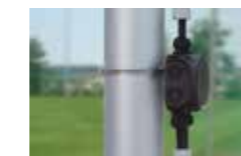
Beleuchtungssteuerung eines Sportplatzes
