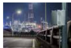
Straßenbeleuchtung in einem Gewerbegebiet
